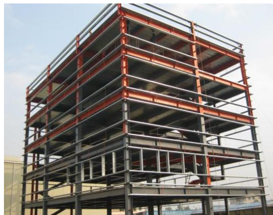
(a) 鉄骨ラーメン
