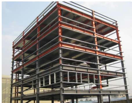
(a) 鉄骨ラーメン
